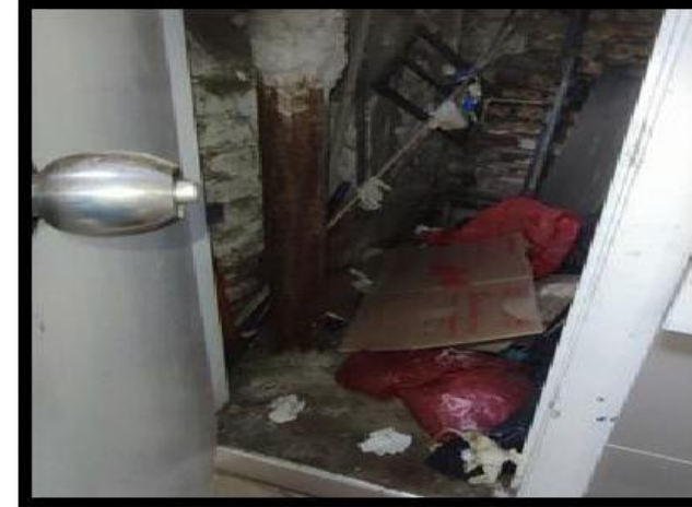
IMAGEN 2. Ducto, materiales inservibles y residuos acumulados.
